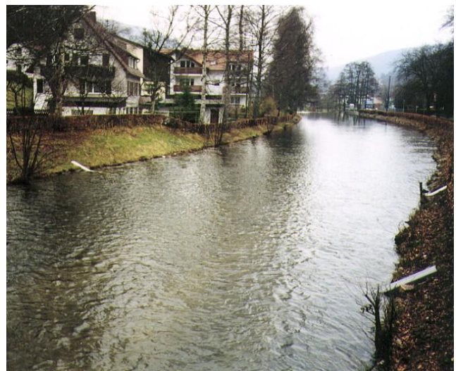
Bild 1: Ultraschall-Durchflussmessanlage in einem Fließgewässer
